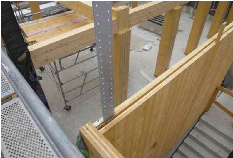
◀ Stahllasche in einer aussteifenden Wand des Erschließungskerns zur Herstellung eines Zugstoßes
