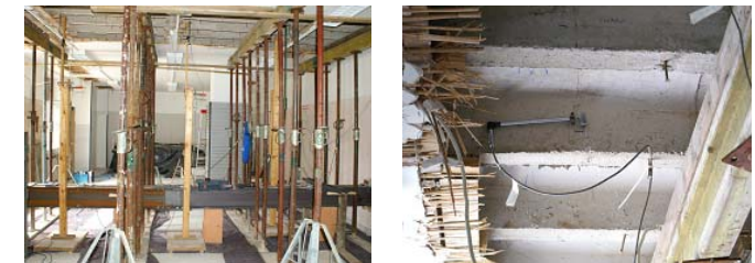
Bild 5: Widerlager (links) und Messpunkt (rechts)
