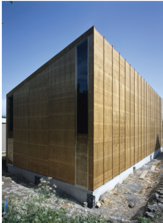
1 Ansicht der Salzlagerhalle © Jörg Hempel
