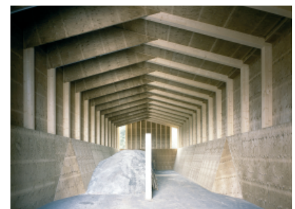
4 Innenansicht der Salzlagerhalle © Jörg Hempel
