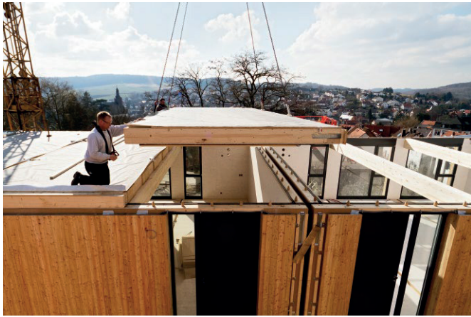
Bild 7 Verlegung eines Deckenelements auf einem Raummodul Installation of a ceiling panel on top of a basic module
