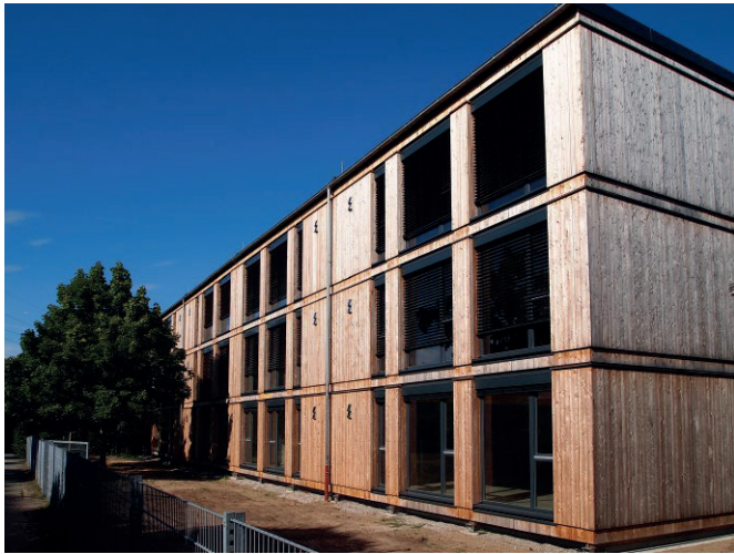
Bild 3 Wiederaufbau als Ersatzbau an der Albrecht-Dürer-Schule in Weiterstadt Re-erected Mobi-Skull at Albrecht-Dürer-school in Weiterstadt
