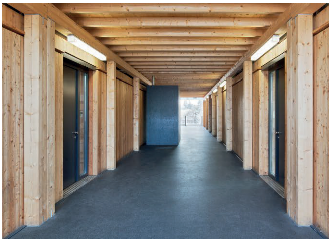
Bild 9 Flur des Mobi-Space mit Stützen-Träger-Konstruktion (l.), Flur der Mobi-Skool ohne Stützen-Träger-Konstruktion (r.) Corridor area of Mobi-space with a beam-column-structure (l.), corridor area of Mobi-Skool without an additional structure (r.)
