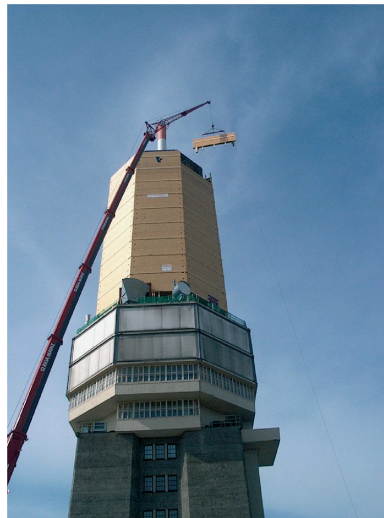
10 11 Montage der Segmente © alle Abb.: bauart Konstruktions GmbH & Co. KG
