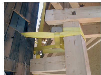
12 Anschluss Gerüst an Turm mittels Zurrurt
