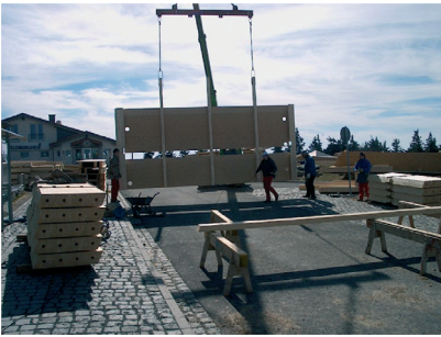
9 Herstellung der Segmente aus vorgefertigten Bauteilen
